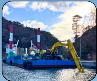
バックホウ搭載時の浚渫作業
