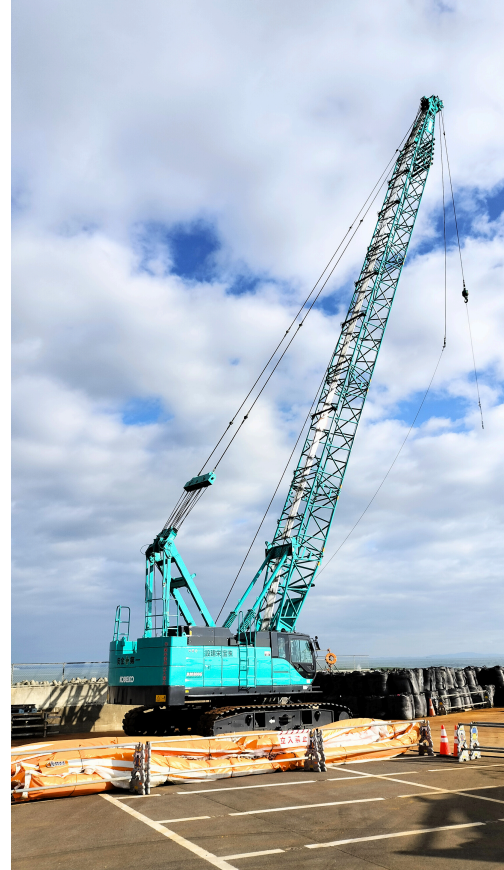
クローラクレーン
